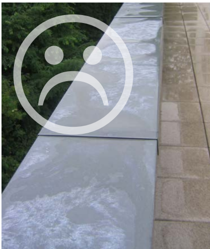
Bildung von Zinkhydroxid durch unzureichendes Gefälle
