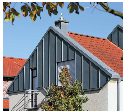
Nakrywa ściany szczytowej dachu dwuspadowego
