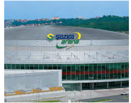
Hala widowiskowo-sportowa, Praga, Czechy
